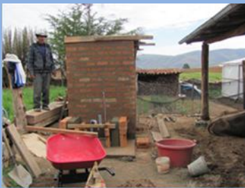
Instalando un Baño Seco
